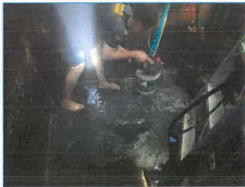
ภาพถ่ายที่ 2.2-11(2) การล้างทำความสะอาดถึงน้ำใช้และระบบกรองน้ำใช้ (ต่อ)
