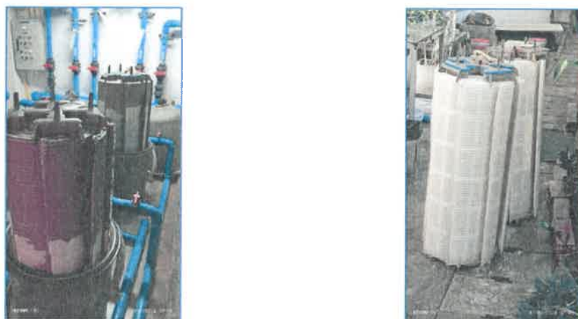
ภาพถ่ายที่ 2.2-11(2) การล้างทำความสะอาดถังน้ำใช้และระบบกรองน้ำใช้
