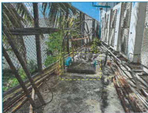
ภาพถ่ายที่ 2.2-16(2) ระบบท่อ vent พิธีเพื่อระบาย ก๊าซมีเทน
