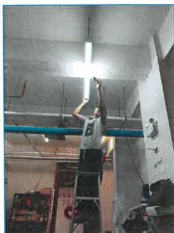
ภาพถ่ายที่ 2.2-27 การทำความสะอาดหลอดไฟส่องสว่างของเจ้าหน้าที่
